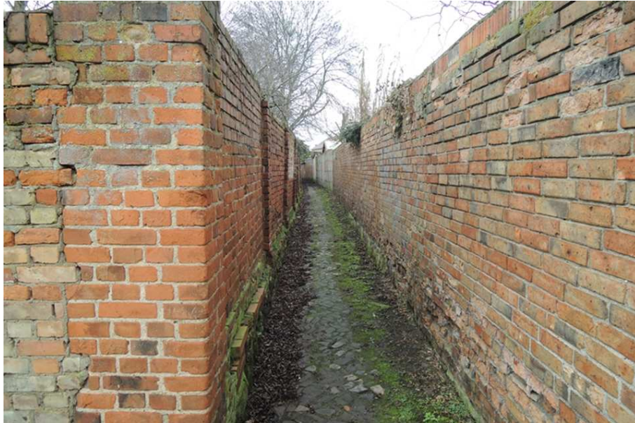
Der Wassergang in Klein Ottersleben (Blickrichtung nach Osten)
