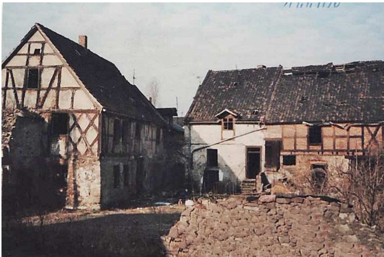
Alter Fachwerk-Bauernhof von vor 1800
